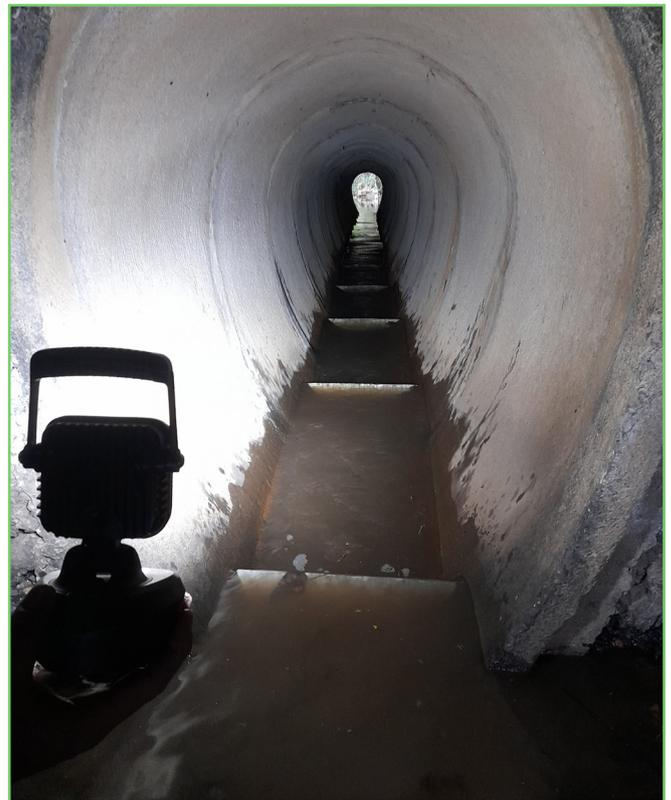
Pose de déflecteurs : sortes d'escaliers permettant aux poissons de passer un obstacle tel qu'un pertuis ©CRSenne
