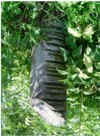
Borne de pierre bleue lachérée par les câbles de traction des bateaux (gauche)
